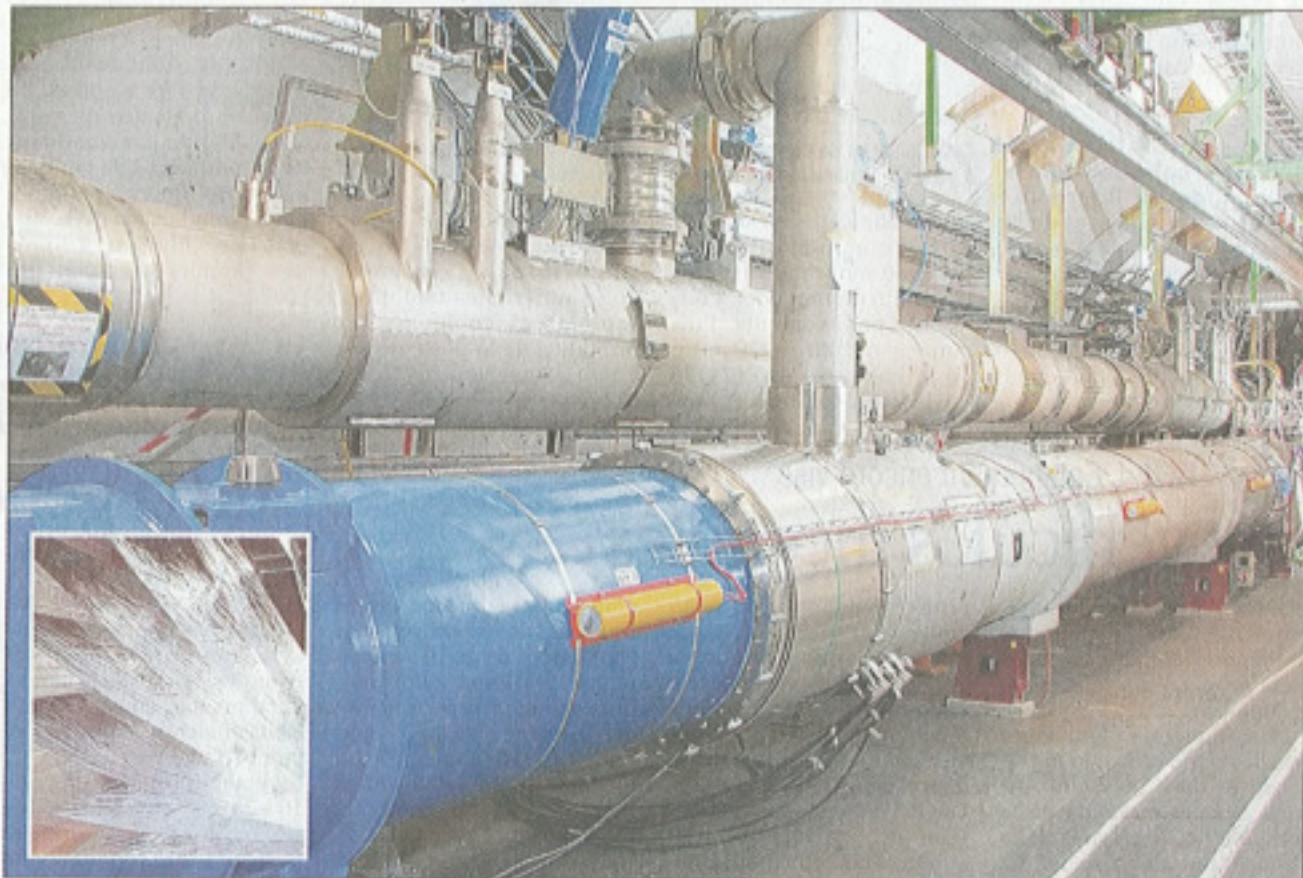
Long de 27 kilomètres, le flux de protons est "tordu" par 1746 aimants supraconducteurs. À refroidir. Et à conserver en température grâce à la technologie développée par Rexor : des couches successives de films métallisés.
